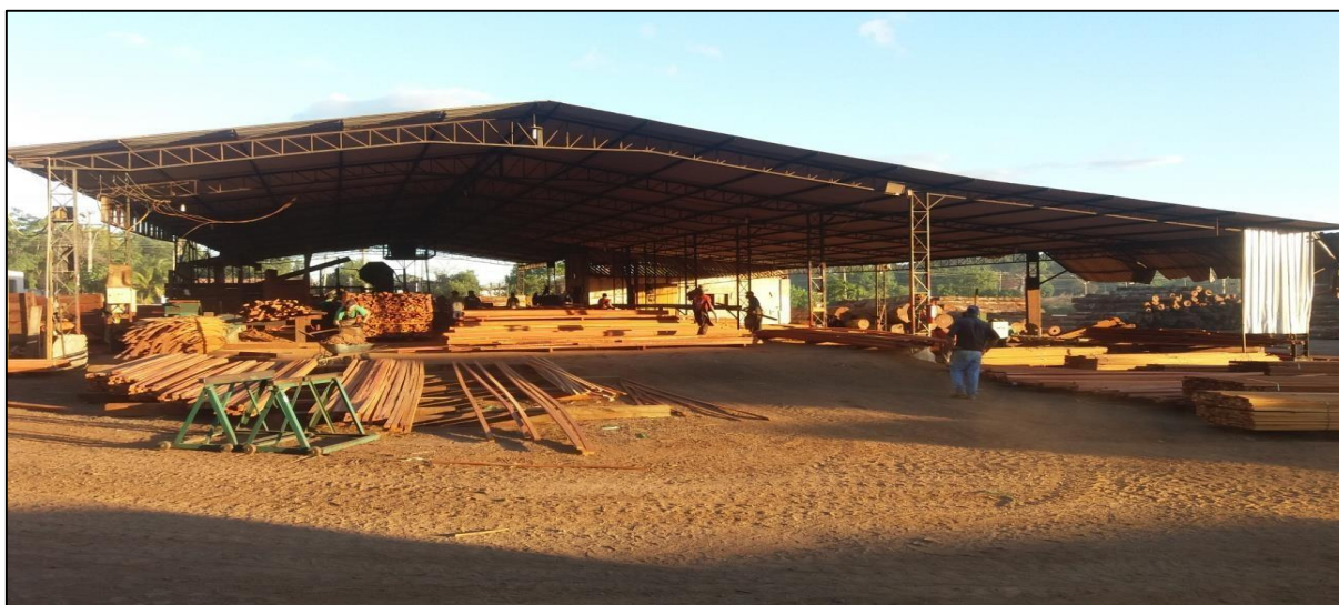
Foto 1 - Estado de Roraima. Distrito Industrial de Boa Vista. Aspecto de um Galpão de uma Indústria Madeireira, março de 2017.
