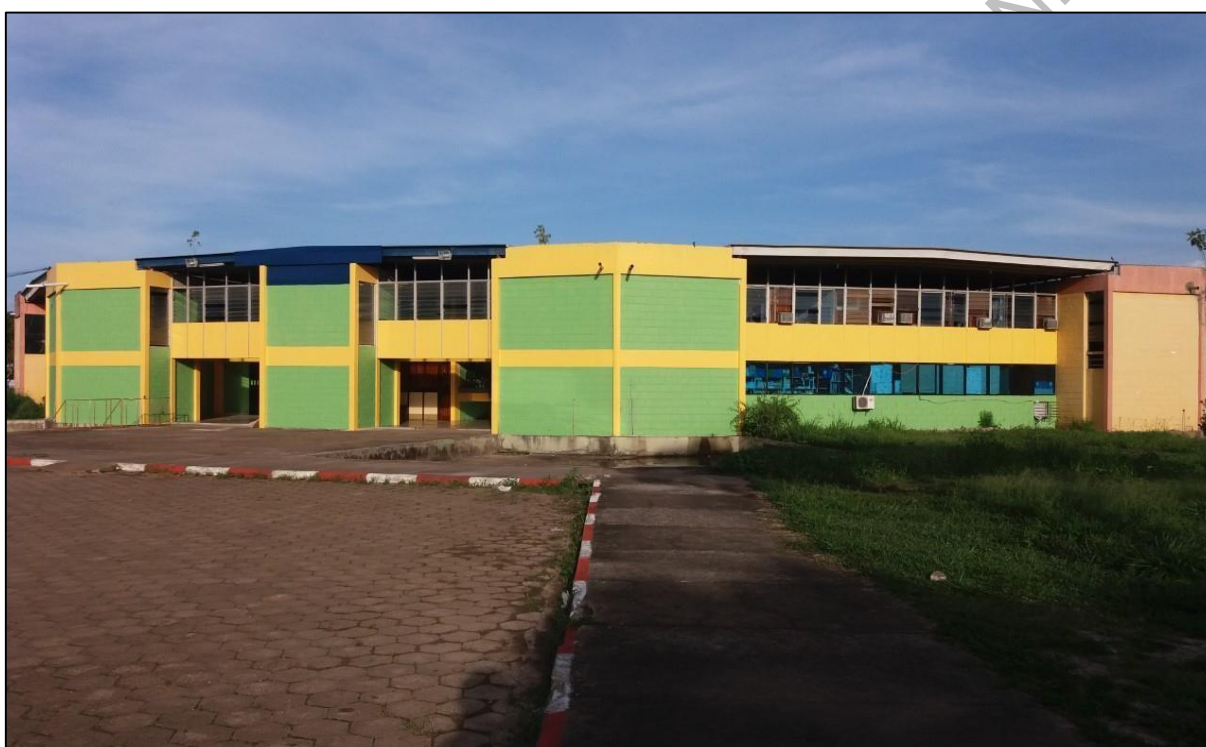
Foto 14 - Estado de Roraima. Município de Caracaraí. Centro de Convenções.
